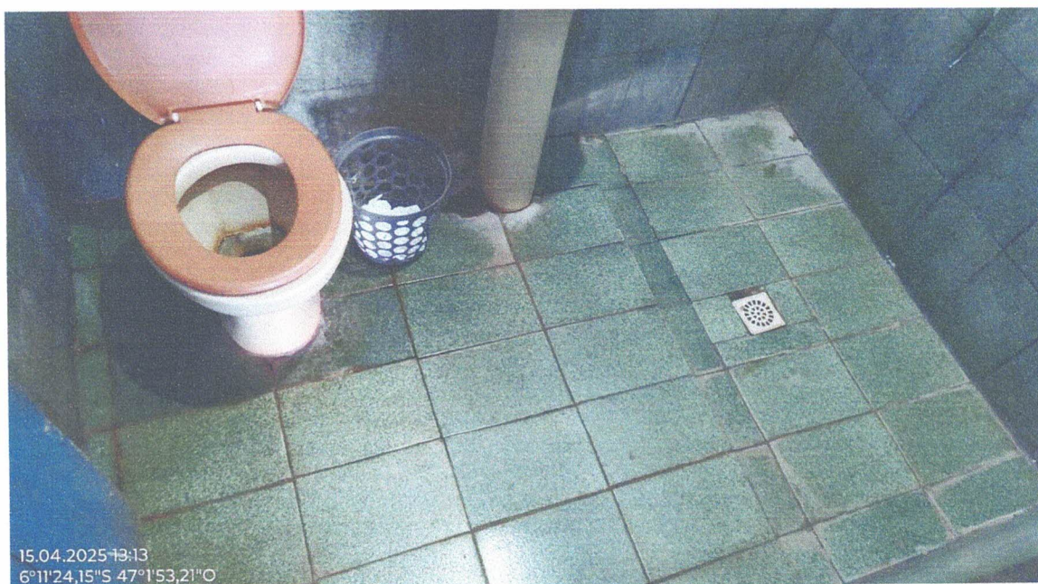
Figura 9 – Banheiro – Fonte: elaboração própria
