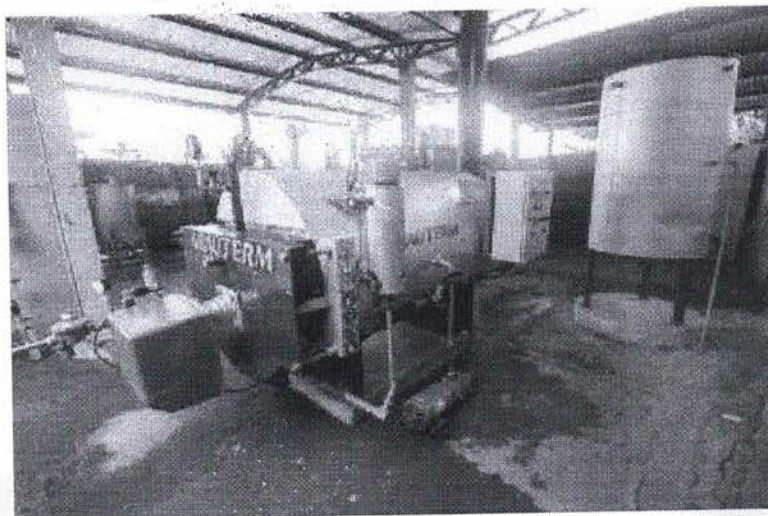
Imagem 14 – Autoclave em fase de Instalação.
