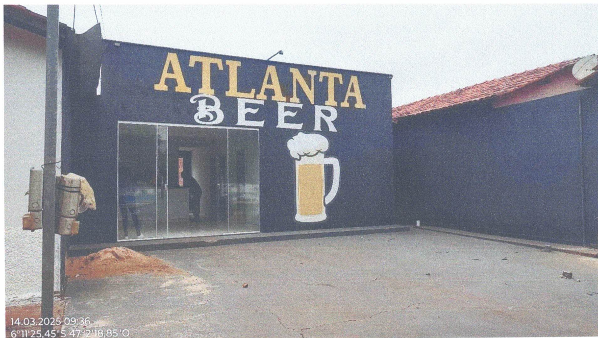
Figura 2 – Fachada Frontal. Fonte: elaboração própria
