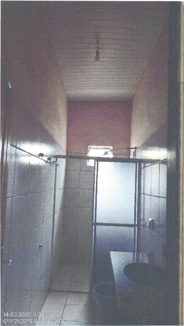
Figura 6 – Banheiro 01 - Fonte: elaboração própria
