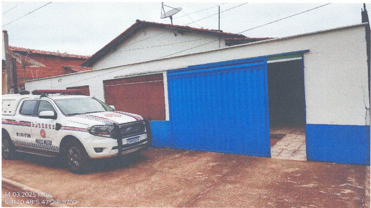
Figura 2 – Fachada Frontal. Fonte: elaboração própria
