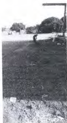
Foto nº 05: Local da caixa de inspeção
